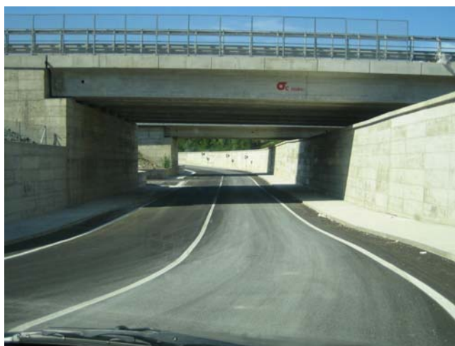
Foto 2 –particolare della strada di Mociano che passa al di sotto del raccordo, con il muro di protezione in c.a.
