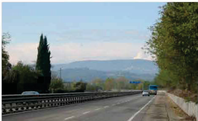
Visibilità lungo il raccordo autostradale Firenze - Siena
