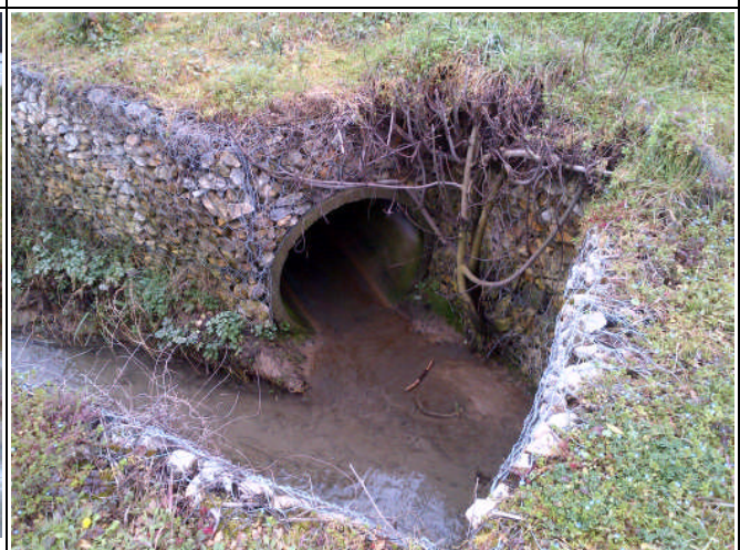
SCARICO 12 – \Phi=90 cm, H base=94,64 m s.l.m.
