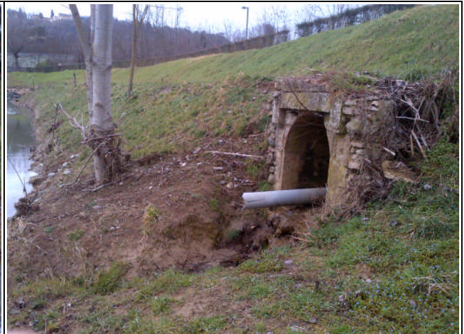
SCARICO 3 – \Phi arco=100 cm, H tratto vert.=70 cm, H base=100,99 m s.l.m.
