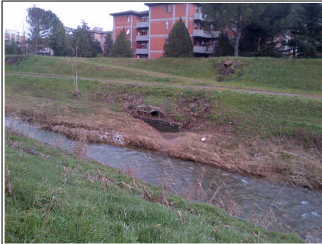
SCARICO 1 – \Phi=60 cm, H base=98,49 m s.l.m.
