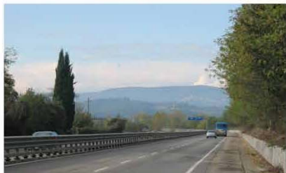
Visibilità lungo il raccordo autostradale Firenze - Siena
